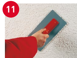
11 Nanošenje završno-dekorativne žbuke (mineralna, silikatna, silikat-silikonska ili silikonska)
