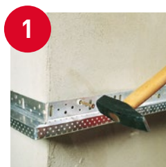
1 Postavljanje početnog (sokl) profila
