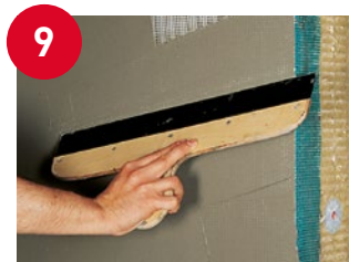
9 Nanošenje drugog sloja morta za armiranje u debljini 1-2 mm
