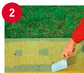
2 Nanošenje kontaktnog sloja na unutrašnjoj strani ploče - po rubovima i u sredini ploče
