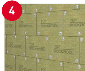
4 Polaganje ploča - jedna do druge s pomakom od pola ploče u idućem redu
