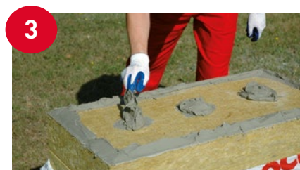
3 Nanošenje morta za lijepljenje na unutrašnjoj strani ploče - po rubovima i u sredini ploče na 2 do 3 mjesta (minimalna kontaktna površina 40%)
