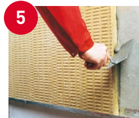
5 Odstranjivanje viška morta za lijepljenje
